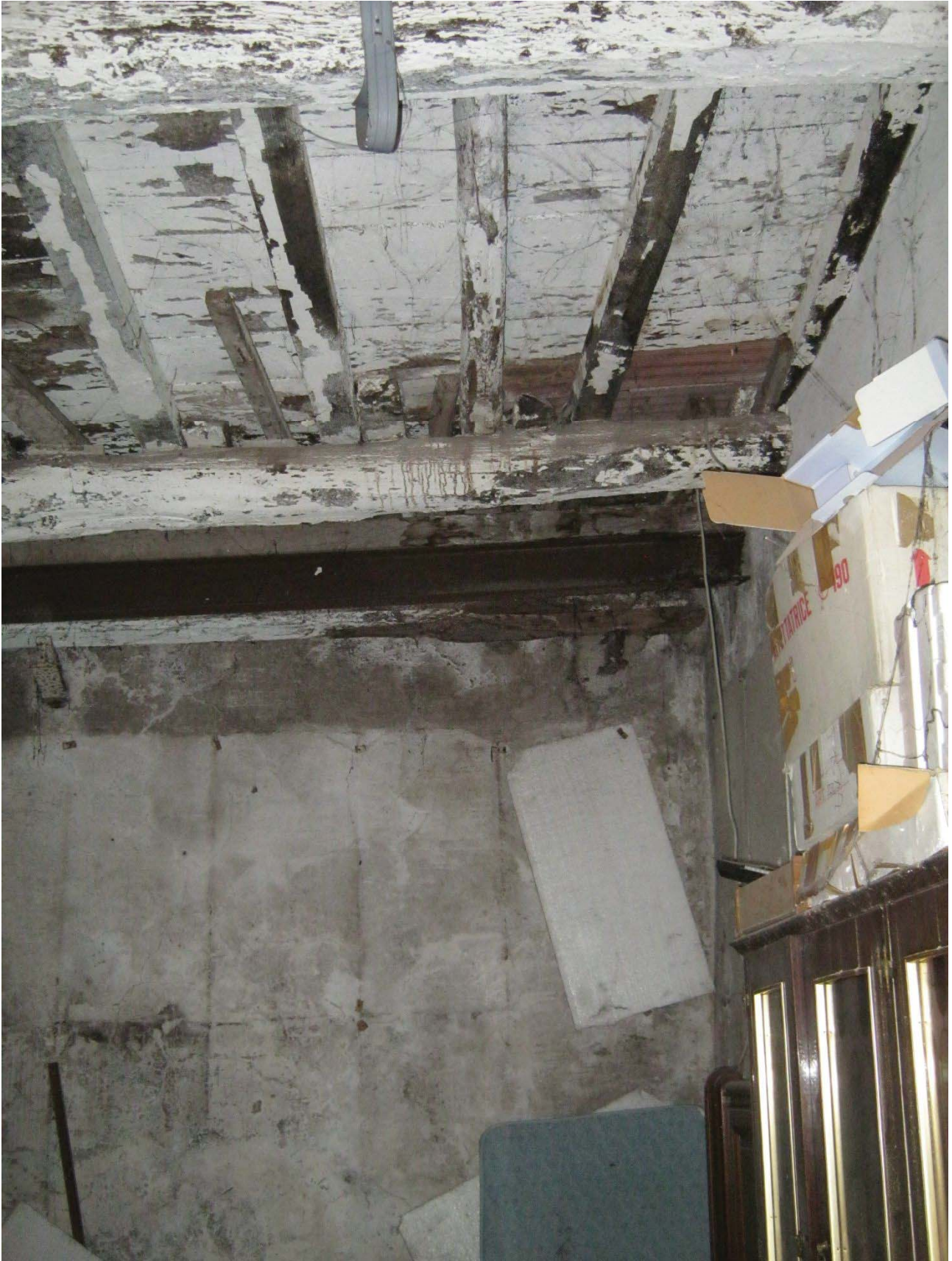
FOTOGRAFIA N.3: solaio interno del magazzino
