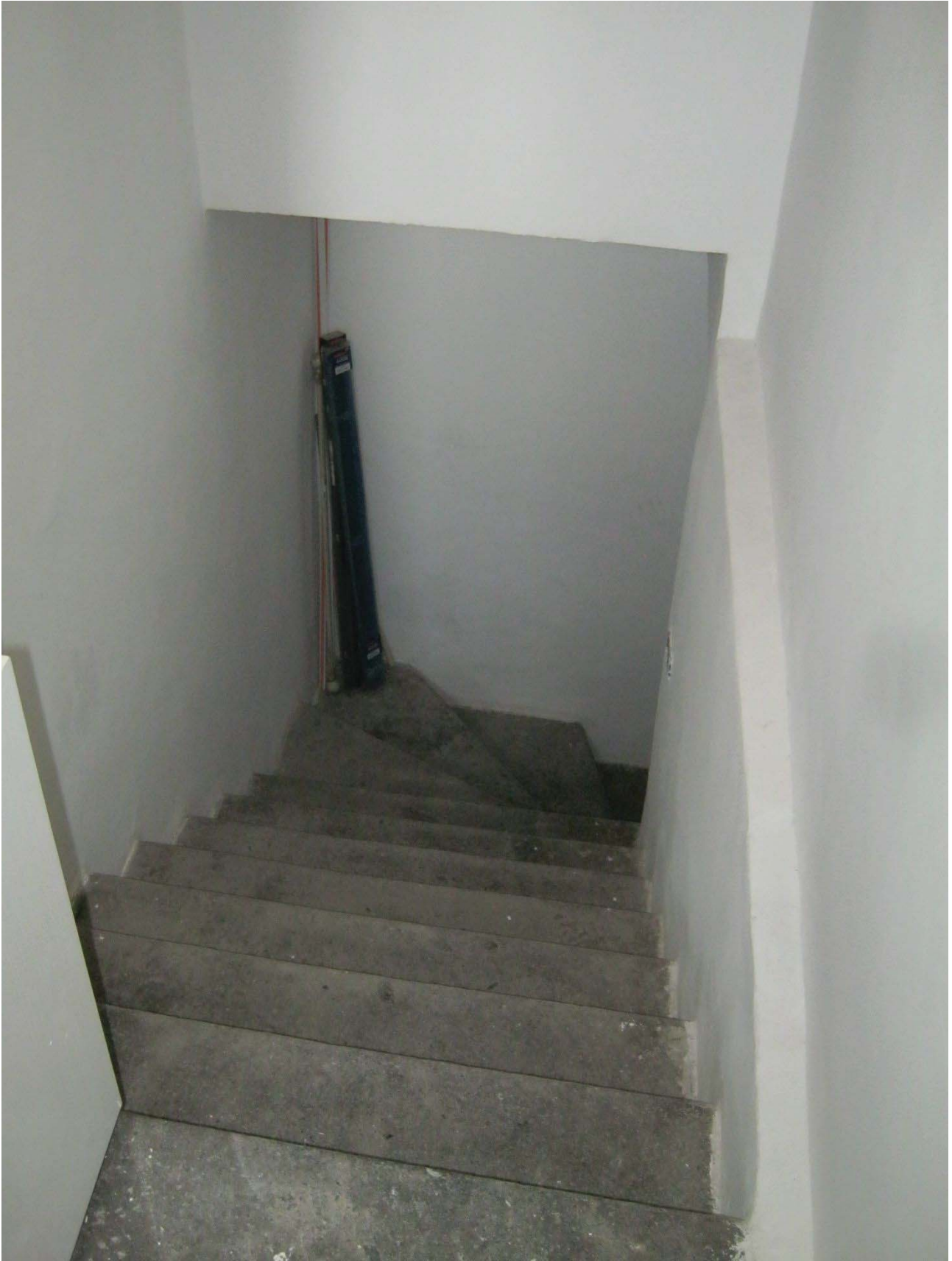
FOTOGRAFIA N.6: scala condominiale interna all'abitazione
