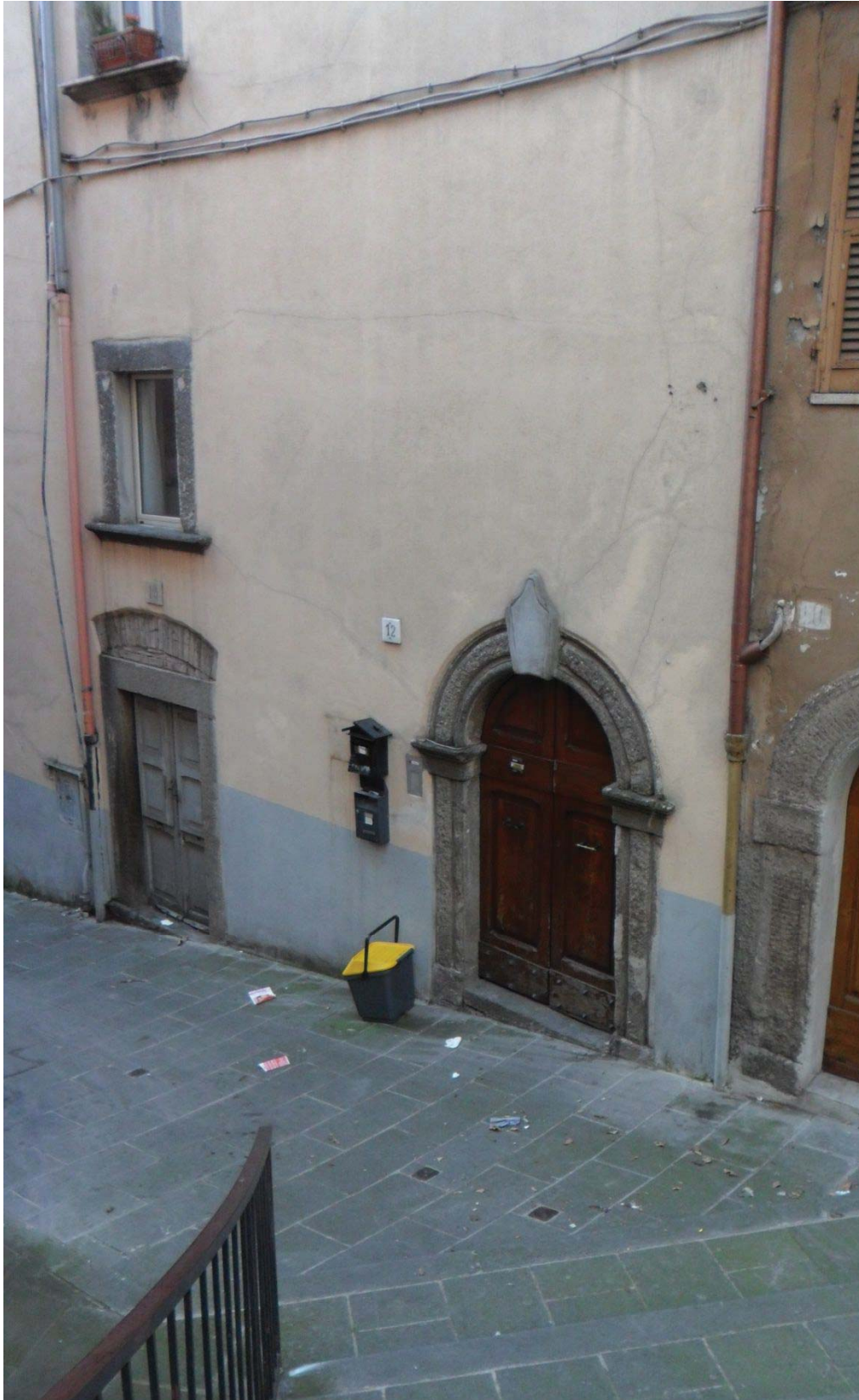
FOTOGRAFIA N.5: ingresso da via Papacqua n.12
